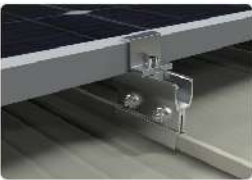
端部押さえ金具の取付
