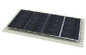
中間、端部押え金具を取付、設置完了
