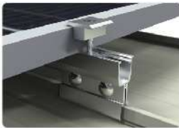
中間押さえ金具の取付
